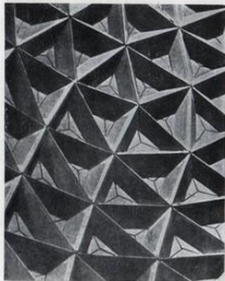
Arh. R. B. Fuller, Cupola geodetică, elemente de car- ton impregnat, 1954
